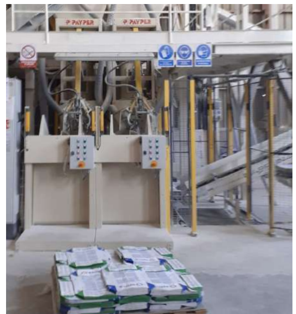
Auffangbehälter für verschüttetes Material
